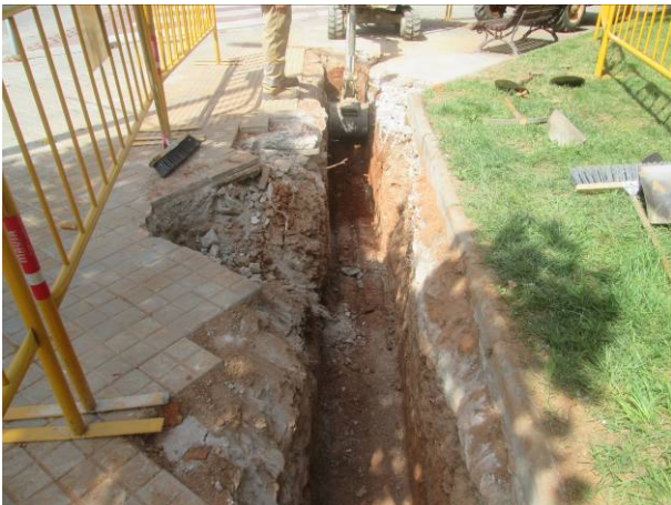
5. Tram 1: rebaix de la rasa
