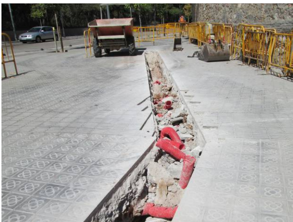
43. Tram 4: Obertura de rasa i localització de serveis
