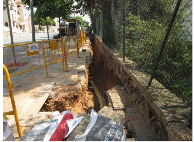
2. Tram 1: Localització de serveis elèctrics.
