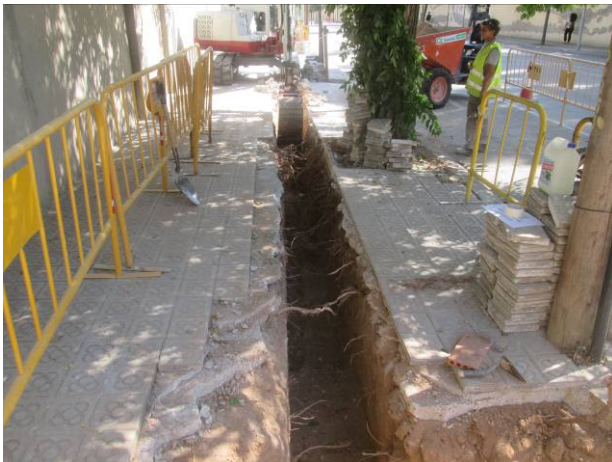
81. Tram 5: Obertura de rasa
