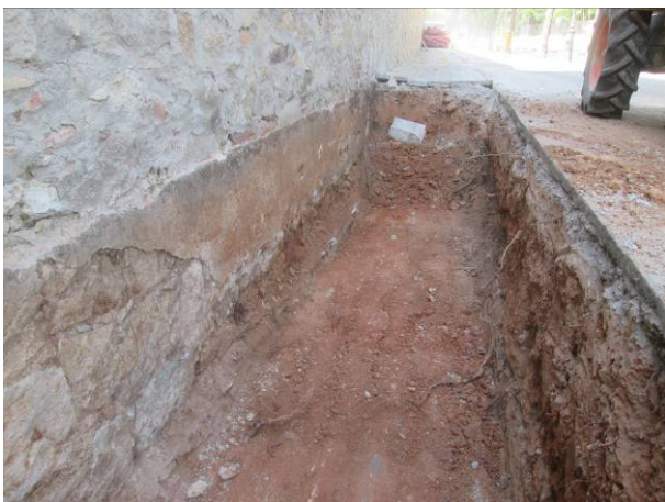
67. Tram 4: Detall de l'enluit del mur perimetral
