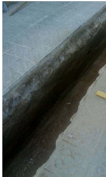
36. Tram 3. Retirada dels panots de formigó
