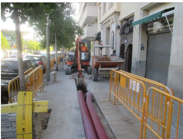
23. Tram 2: Col·locació tubs i obertura de rasa:
