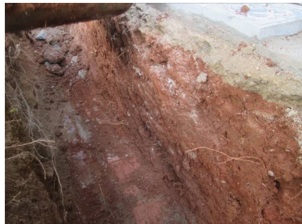
18. Tram 2: Obertura de la rasa per la vorera
