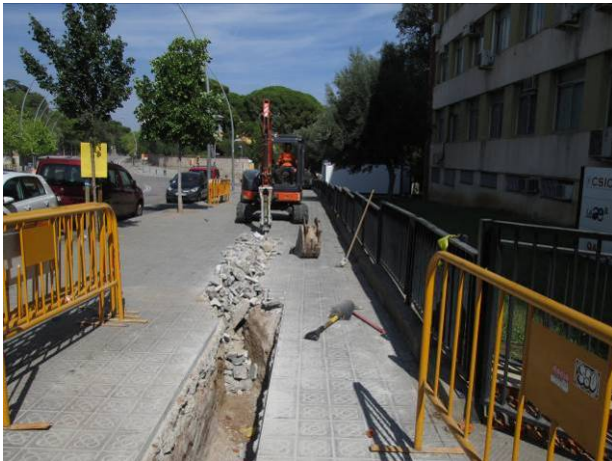
33. Tram 3. Retirada dels panots de formigó
