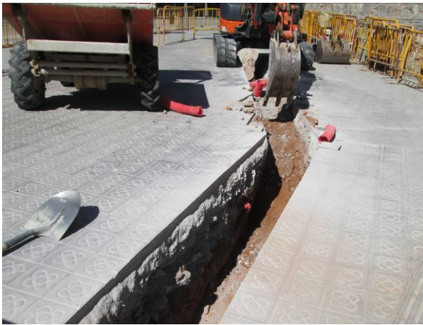
45. Tram 4: Rebaix de la rasa
