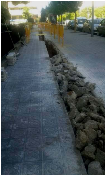
35. Tram 3. Retirada dels panots de formigó.
