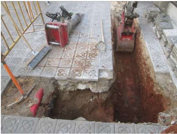
13. Tram 2: Obertura de la rasa per la vorera
