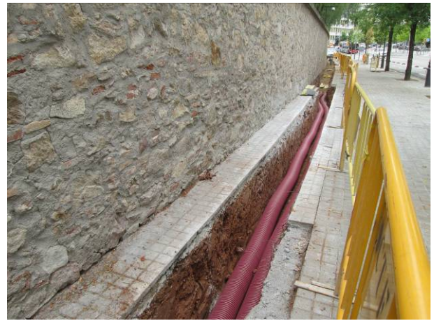
46. Tram 4: Col·locació de tub en un tram del traçat.
