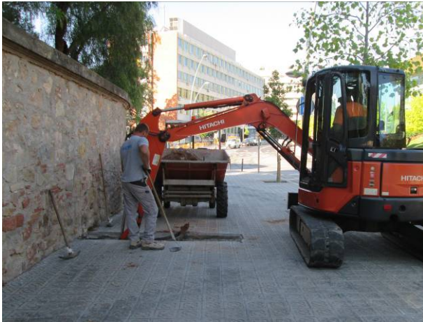
41. Tram 4: Cales de localització de serveis
