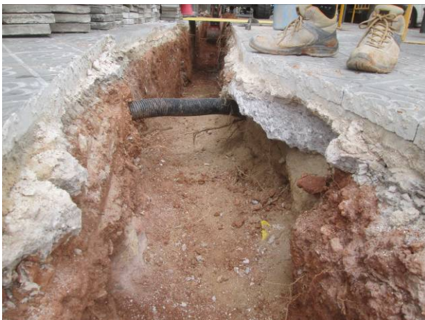
17. Tram 2: Obertura de la rasa per la vorera
