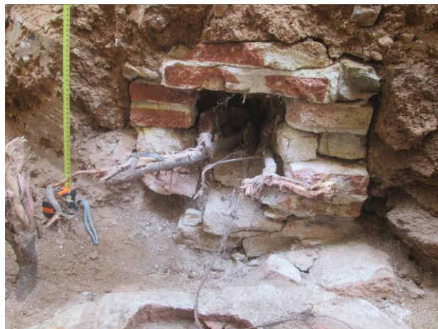
57. Tram 4: Canalització UE 14
