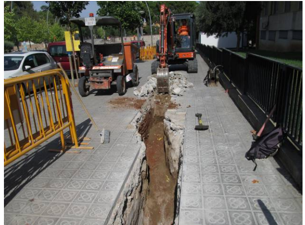
34. Tram 3. Retirada dels panots de formigó
