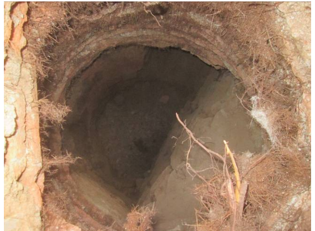
54. Tram 4: Interior pou de registre
