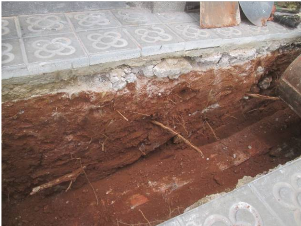
15. Tram 2: Obertura de la rasa per la vorera
