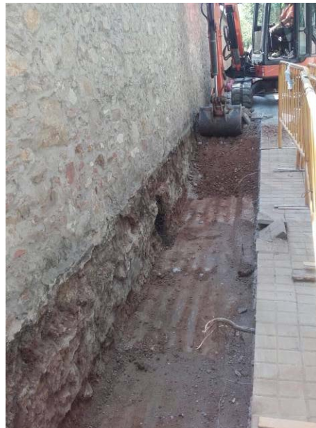
60. Tram 4: Obertura de la rasa
