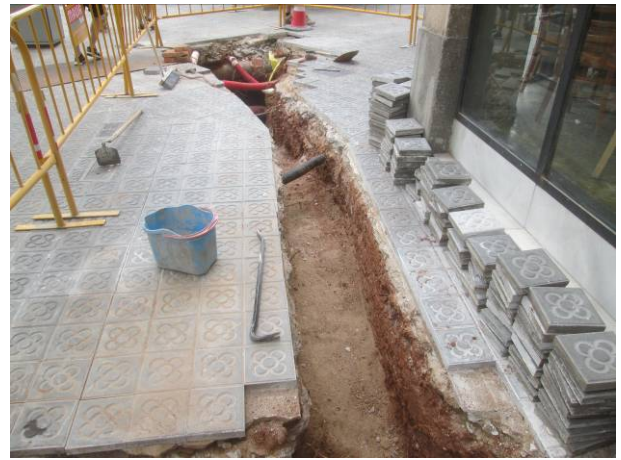
14. Tram 2: Obertura de la rasa per la vorera
