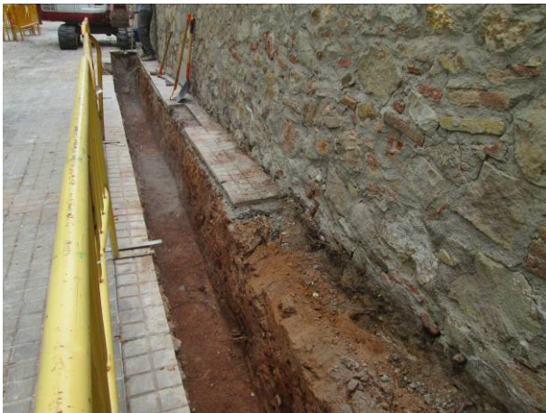
47. Tram 4: Obertura de rasa
