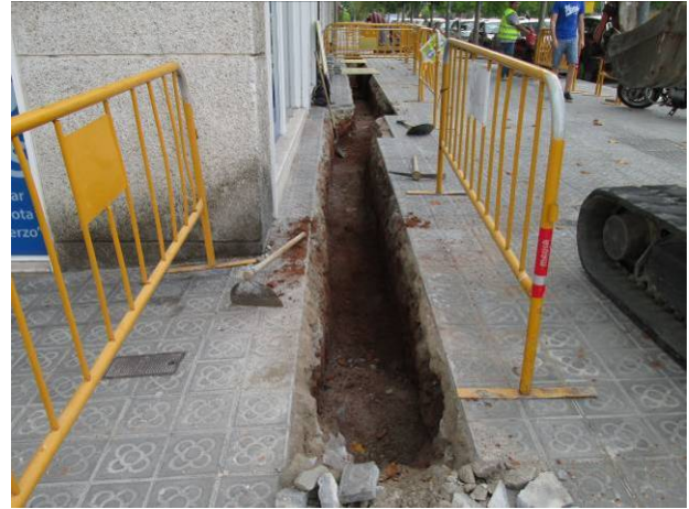
26. Tram 2: Obertura de rasa
