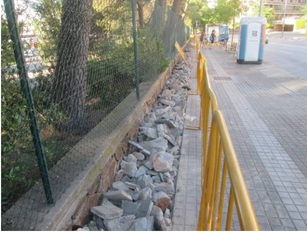
1. Tram 1: Retirada del formigó de la vorera
