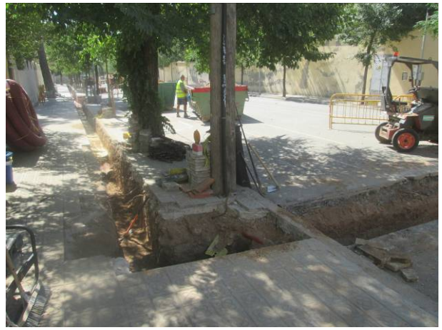
84. Tram 5: Obertura de rasa i cruïlla
