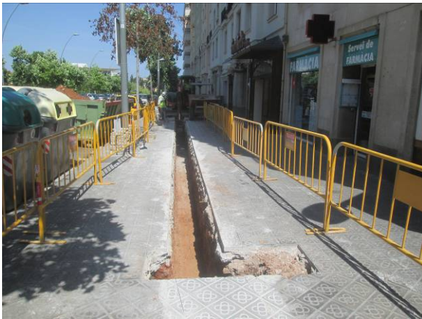
21. Tram 2 vista de la rasa.
