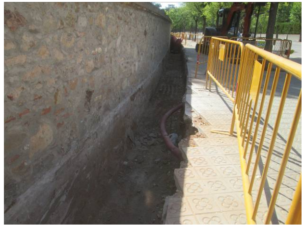
70. Tram 4: Detall de l'enlluït del mur perimetral
