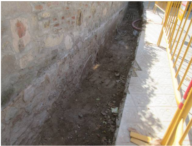
69. Tram 4: Detall de l'enlluït del mur perimetral
