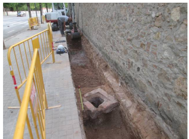
50. Tram 4: Brocal UE 7 i fonamentació del mur UE 11
