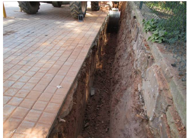
4. Tram1: rebaix de la rasa
