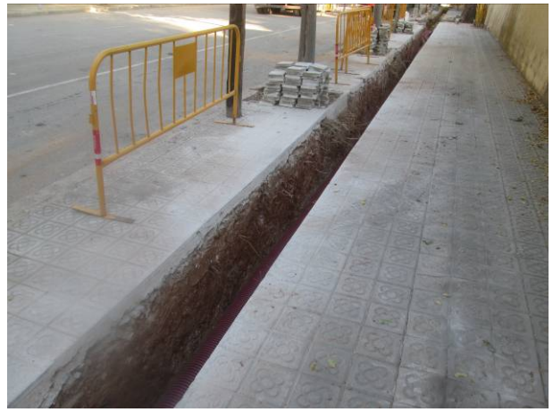
82. Tram 5: Obertura de rasa
