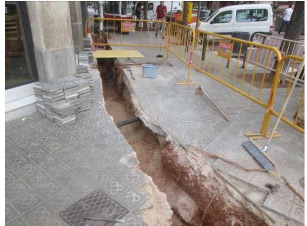
16. Tram 2: Obertura de la rasa per la vorera
